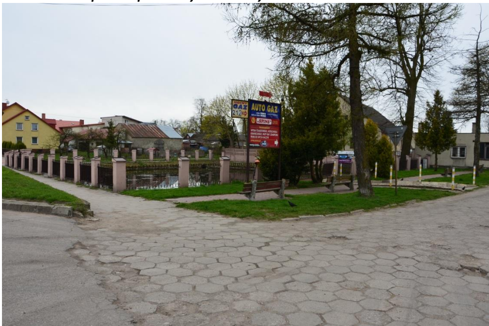
Fot. 4 Zbiornik przeciwpożarowy w Szczuczynie
